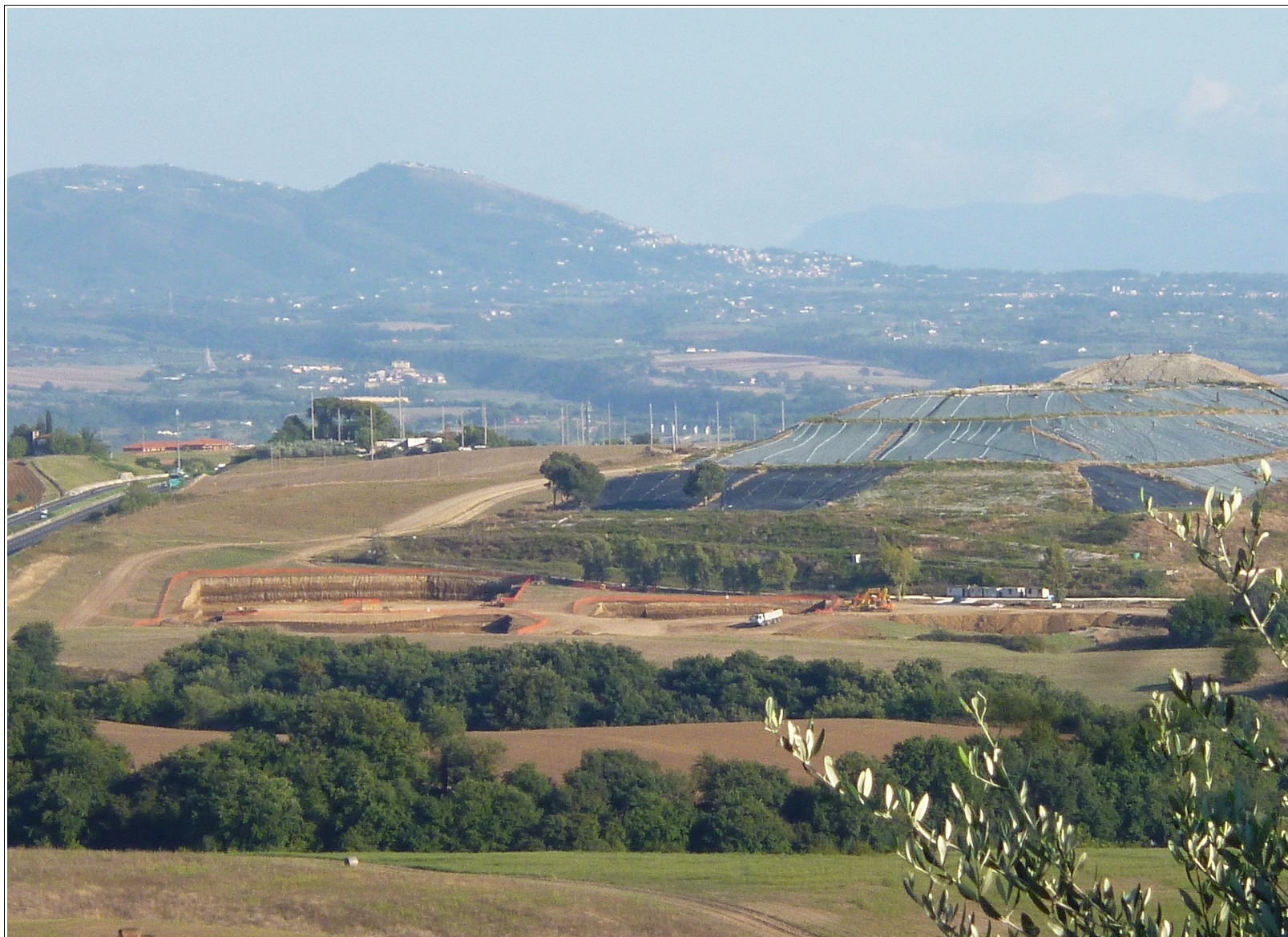
Lavori al TMB Inviolata, 14 settembre 2013
